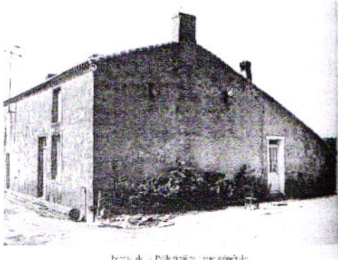
ferme de la Pellerinière - vue générale.
